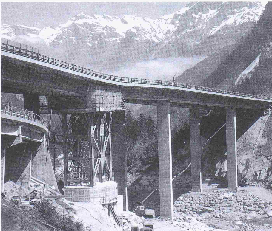
Wiederinstandstellung der Brücke Wassen der Gotthard-Autobahn N2 nach der Hochwasserkatastrophe 1987 – ein aufwendiges Rekonstruktionsobjekt von verkehrspolitisch grosser Bedeutung
