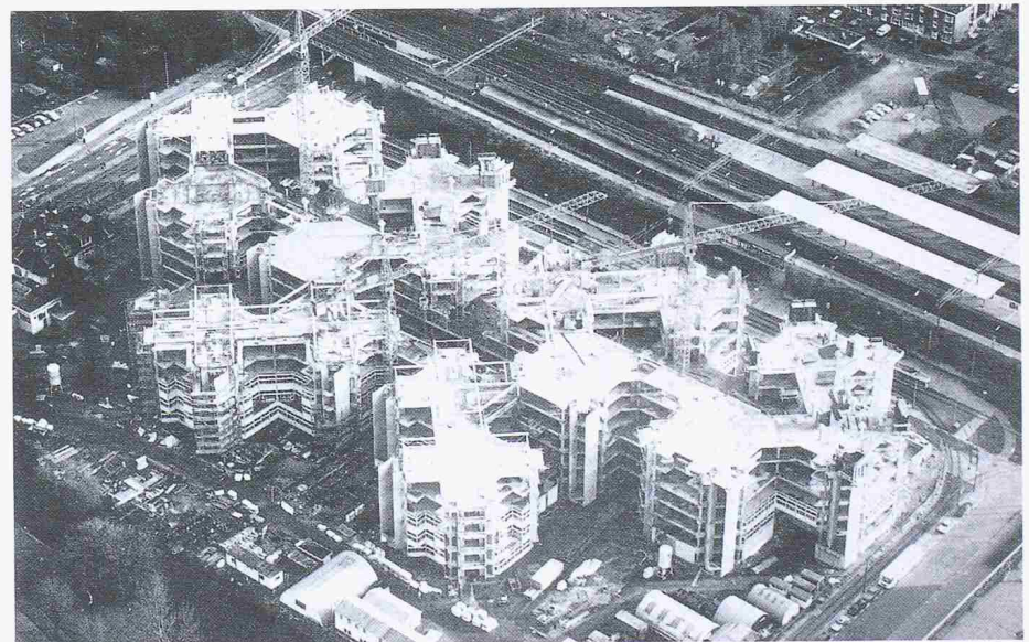
Bild 4. Neubau des Sozial- und Arbeitsministeriums in Den Haag – aufgelöst in 16 Bürotürme aus Stahlbeton- und Spannbetonfertigteilen (Faas)
