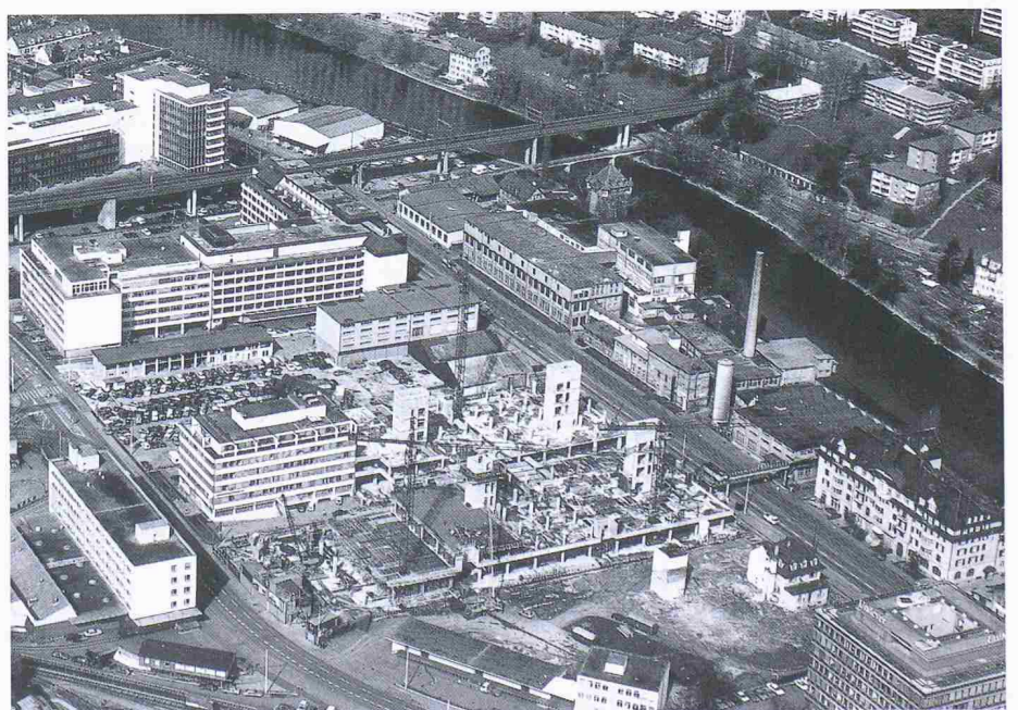
Luftaufnahme. Beidseits des SBB-Viadukts zwischen Limmat und Hardturmstrasse die Areale A und B, Areal C links der Hardturmstrasse
