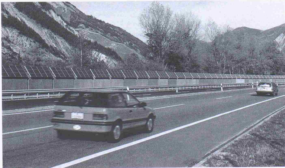
Die Photovoltaik-Anlage (100 kW) entlang der Autobahn N13 bei Chur
