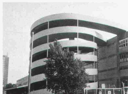
Rampe Parkhaus Migros Herdern
