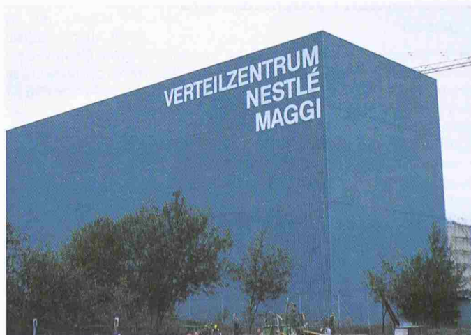
Bild 7. Referenzaufnahme Metallfassade des Nestlé-Maggi-Verteilzentrums; ausgeführt in Silikonpolyesterlack; Baujahr 1972
