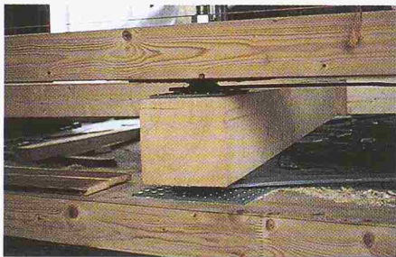
Bild 10. Die Ausführungsqualität von Gelenkbolzen-Verbindungen kann auch nach dem Zusammenbau gut kontrolliert werden. Untergurtanschluss eines Fachwerkes mit Posten aus Holz und Diagonalen aus Stahl
