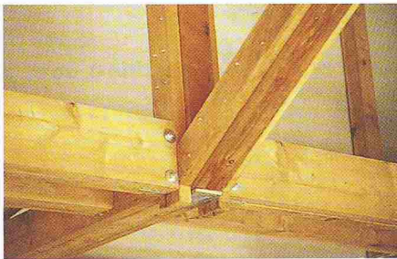
Bild 31. Ansicht des fertig montierten Knotens. Die Verbindung der zusammengesetzten Querschnitte erfolgte mit Schraubnägeln
