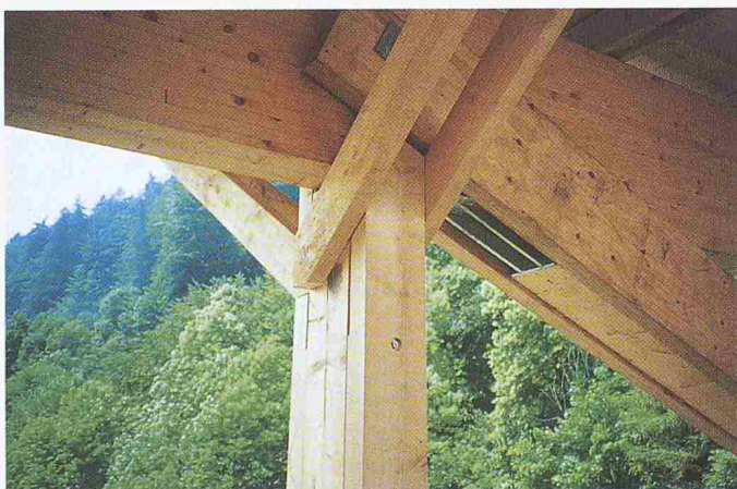
Bild 35. Die Verbindungen zur Aufnahme der grossen Stabkräfte (bei diesem Obergurt-Knoten 700 kN Druck in der Diagonalen und 350 kN Zug im Pfosten) sollten möglichst diskret wirken
