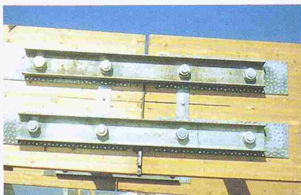
Bild 39. Montagestoss des Hauptbinders. Die Arbeit auf der Baustelle beschränkte sich auf den Einbau der Gelenkbolzen
