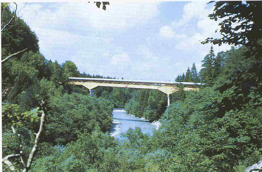
Bild 34. Ansicht der fertigen Brücke
