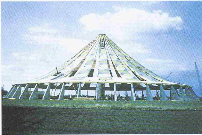
Bild 37. Die rotationssymmetrische Anordnung von 48 Hängerippen ergab die gewünschte markante Gebäudeform
