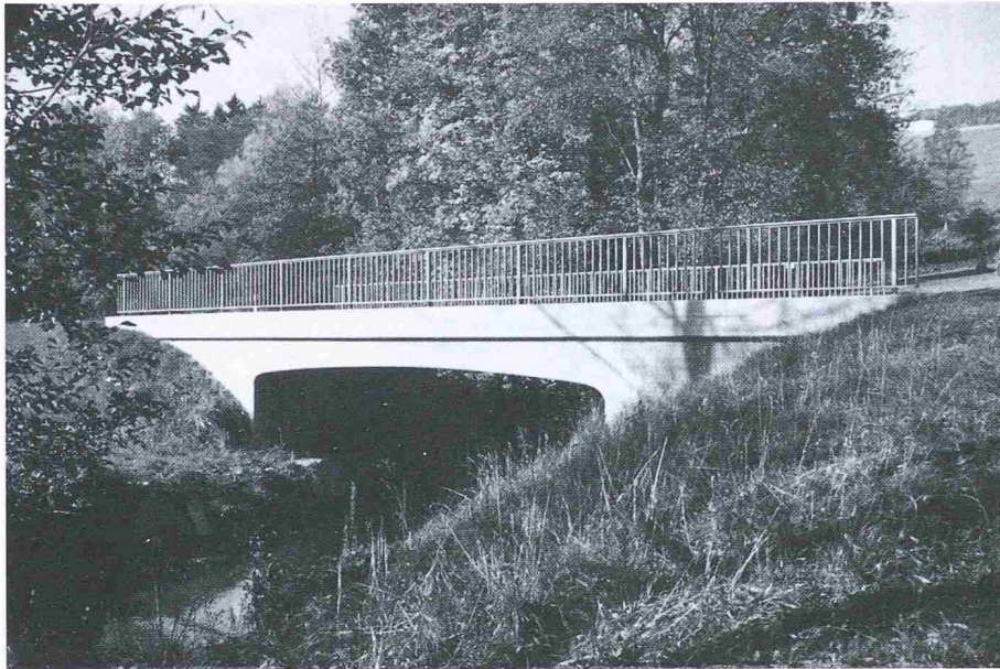
Bild 16. Zustand nach der Sanierung
