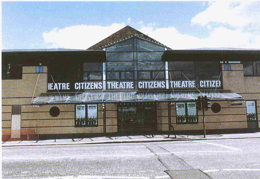
Citizen's Theatre, Foyeranbau mit «Gesicht» zur Strasse
