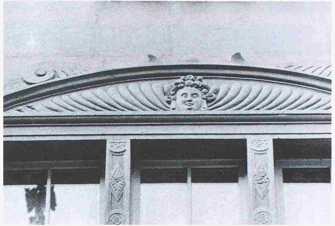
Bild 11. Bildhauerarbeit aus dem 16. Jahrhundert nach zurückhaltender Aufmörtelung
