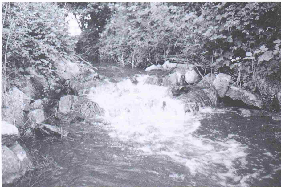
Bild 1. Blockrampe am Mederbach in Marthalen, Blick bachaufwärts
