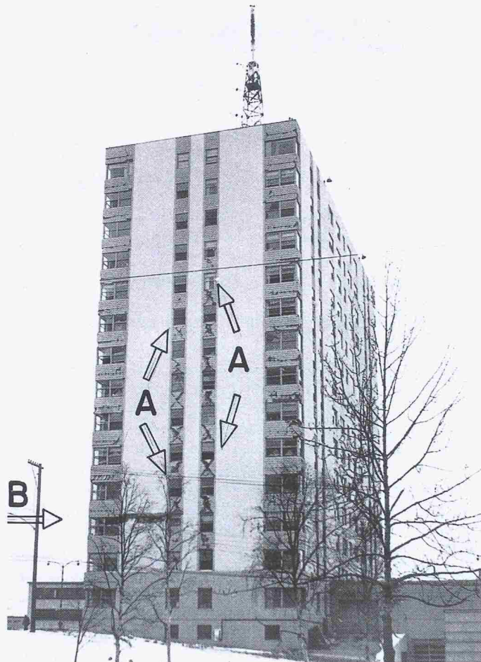
Bild 4. Schäden am Mt. McKinley-Gebäude nach dem Erdbeben von Anchorage, 1964, Alaska
