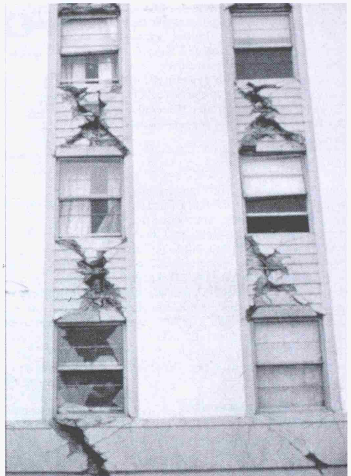
Bild 4. Schäden am Mt. McKinley-Gebäude nach dem Erdbeben von Anchorage, 1964, Alaska
