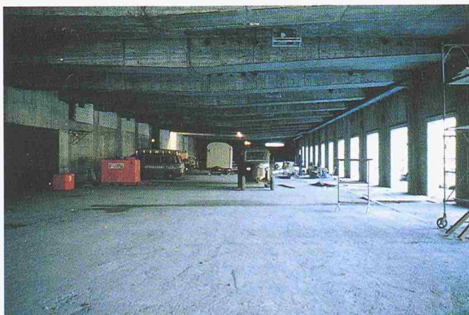
Bild 6. IKEA, vorgespannte Rippen
