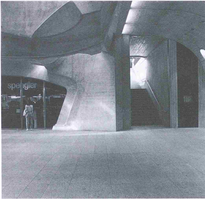
Bild 5. Untergeschoss: Stützen des Gleistroges, Durchlass des Tageslichtes
