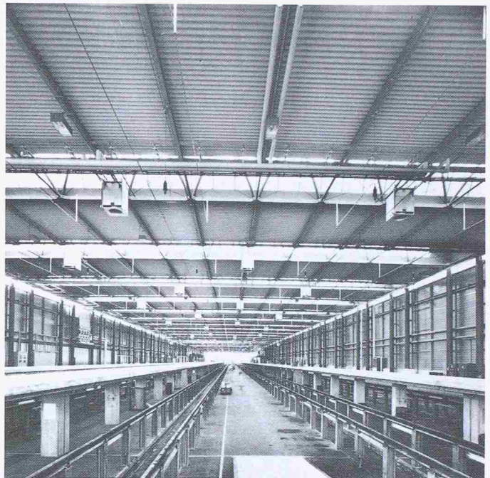
Bild 2. Innenansicht der grossen Halle
