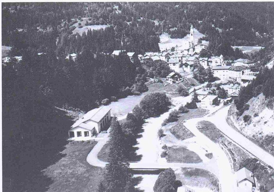
Bild 1. ALK, «Zentrale Tiefencastel der Albula-Landwasser Kraftwerke AG»
