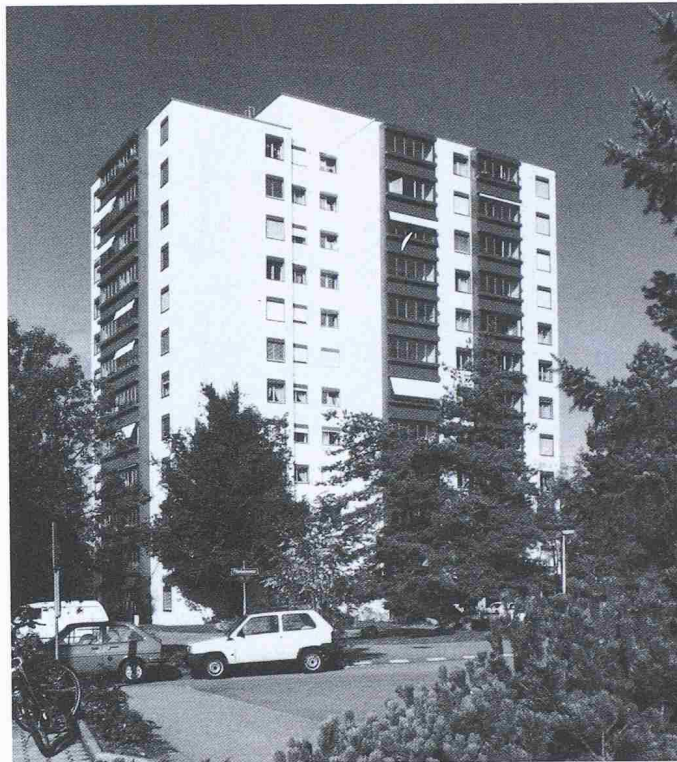
Bild 1b. Zustand nach der Fassadensanierung. Massgebend für die Auszeichnung war neben der Sanierung der Haustechnik die gute konstruktive Lösung der hinterlüfteten Fassade mit Keramikplattenverkleidung sowie die Integration der Balkone mit Faltpfenstern
