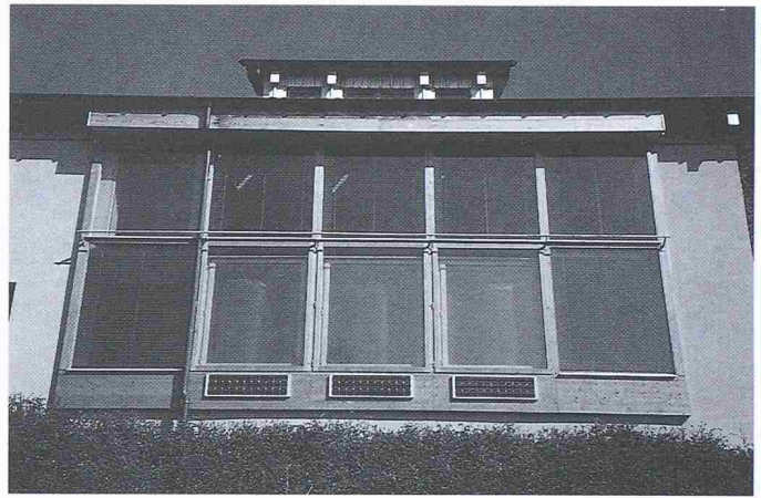
Bild 2b. Der Fensterkollektor, in dem warme Luft erzeugt und mit photovoltaischen Zellen in die Betonwände des Schwimmbeckens im Hausinnern gebracht wird. Unten die Fischtanks, die durch direkte Einstrahlung erwärmt werden
