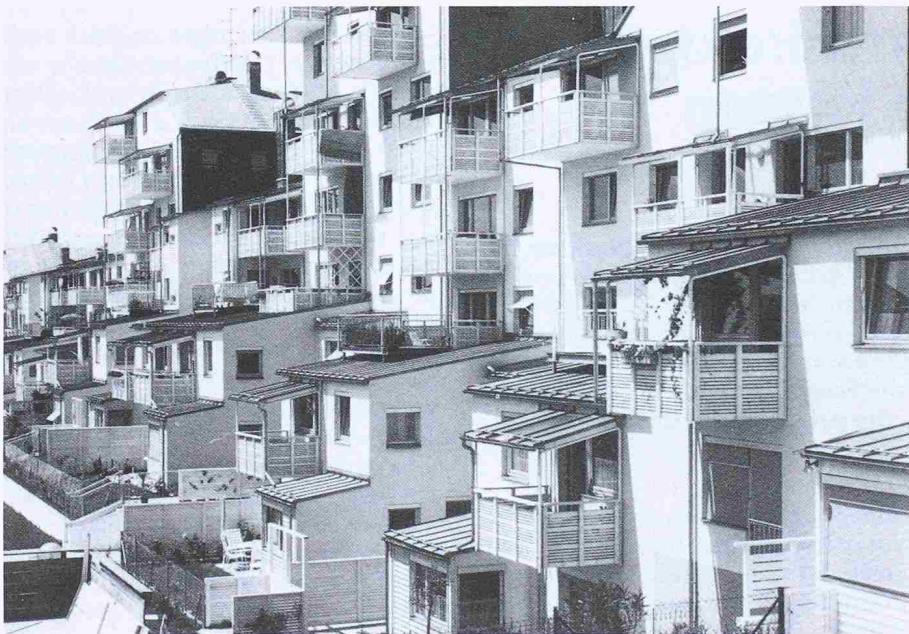
Bild 16. Einfache, glatte Baukörper werden durch angehängte Balkone, Laubengänge und aussenliegende Treppen individuell gestaltet
