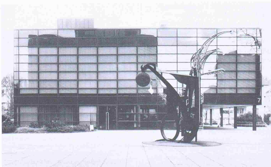
Vor der Ecole professionnelle in Biel (Arch. Baumann + Tschumi) eine Plastik von Tinguely und Luginbühl
