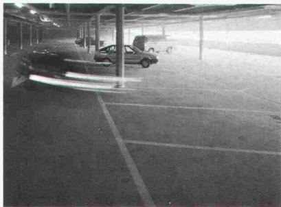
Parkdeck Glattzentrum, Wallisellen
