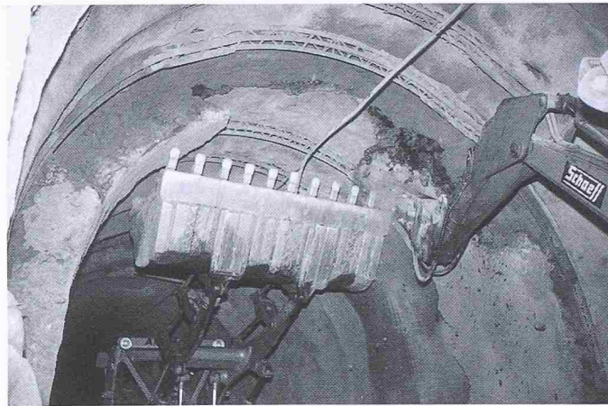
Bild 6. Hydraulischer Abbauhammer auf Bagger (Vordergrund)
