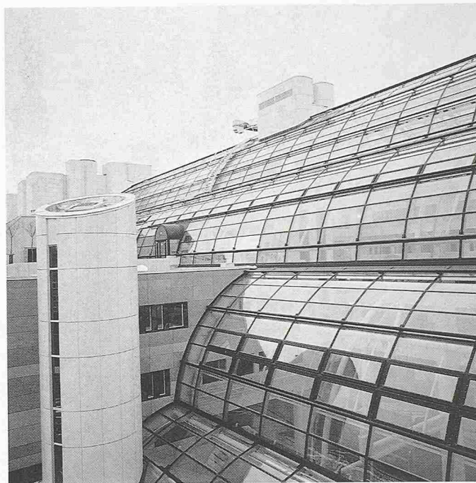
Die 6000 m 2 bedeckenden Glasgewölbe über den Hallen
