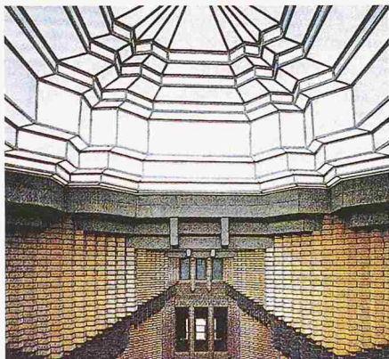
Die Haupthalle wird von drei Glaskuppeln überdeckt
