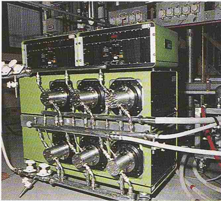
Bild 7. Speziell für die Biotechnologie konstruierte Kolbenpumpen, mit denen steril, volumetrisch und sehr schonend z.B. schערempfindliche Biomasse gefördert werden kann (Bild: Lonza AG, Visp)
