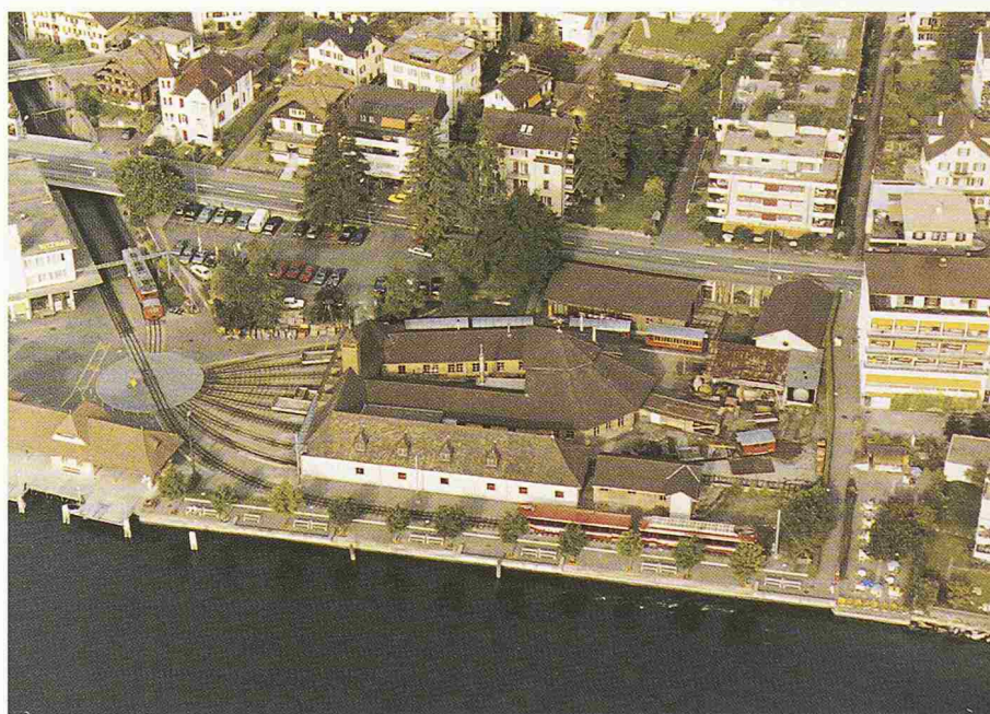
Zweite Depotalanlage, entstanden um die Jahrhundertwende, kurz vor dem Abbruch 1987
