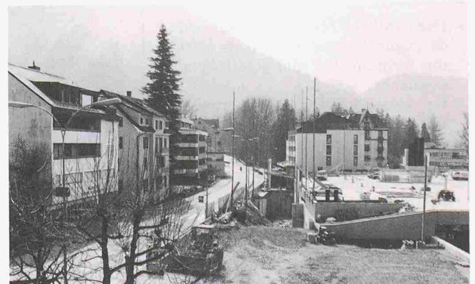
Links Kantonsstrasse, rechts Depot mit Parkdeck und Bau-gespann der Fremdbauten
