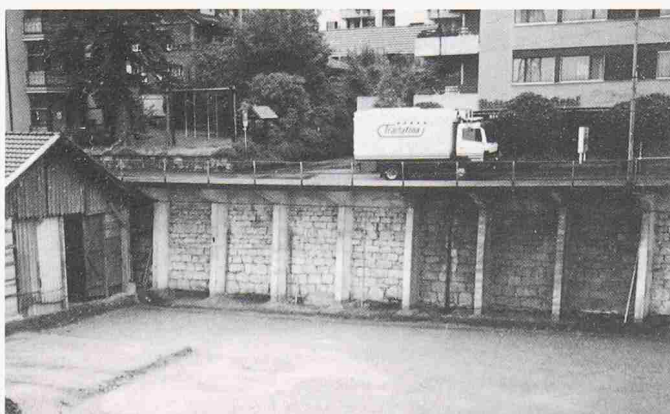
Die fünf Meter hohe Geländestufe zwischen Kantonsstrasse und Bahnareal
