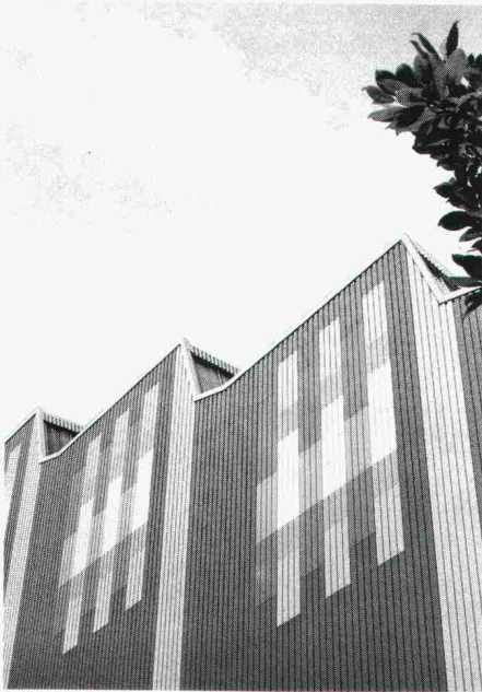
Neues Werk der Montana Bausysteme AG in Villmergen
