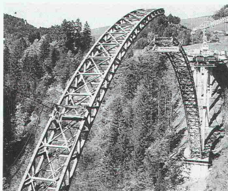
Hundwiler Tobelbrücke, 11. Oktober 1990, Einklappen der Fachwerkbogen
