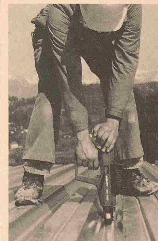
Bolzensetzgerät DX 750: Profilblechnägeln im Sekundentakt
