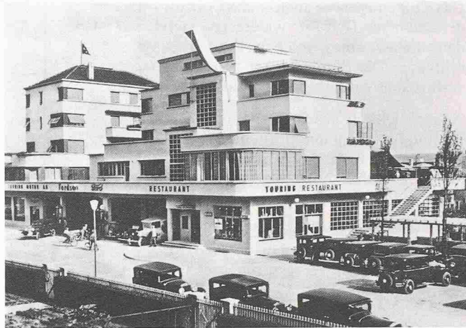
Wohn- und Geschäftshaus Touring, Solothurn, 1931–33. Arch. P. Flury (Foto: Archiv P. Flury)
