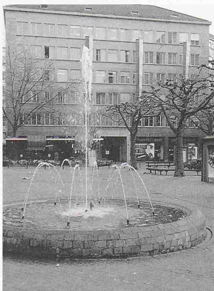
Bild 1. Aussenansicht des Amtshauses V in Zürich
