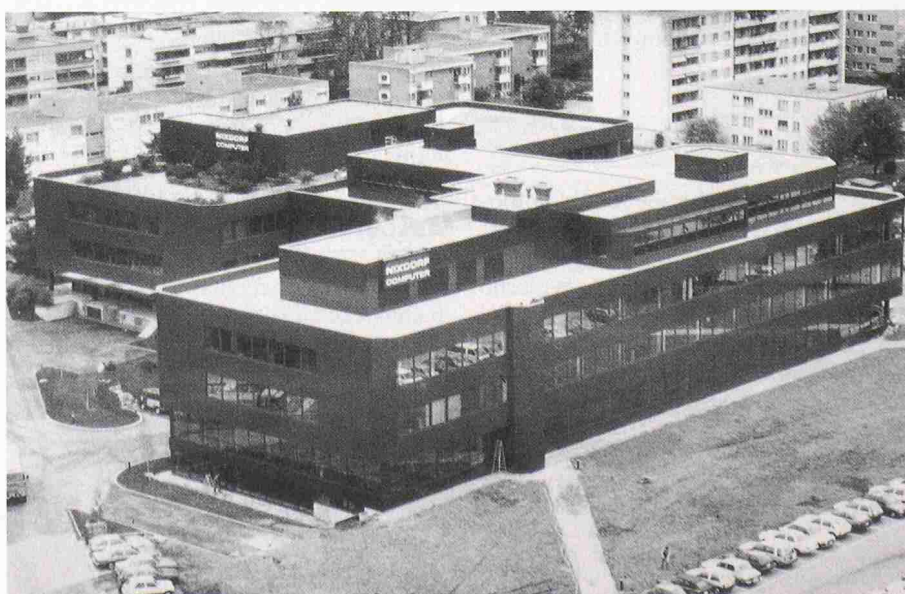
Bild 2. Bürogebäude der Firma Nixdorf in Kloten
