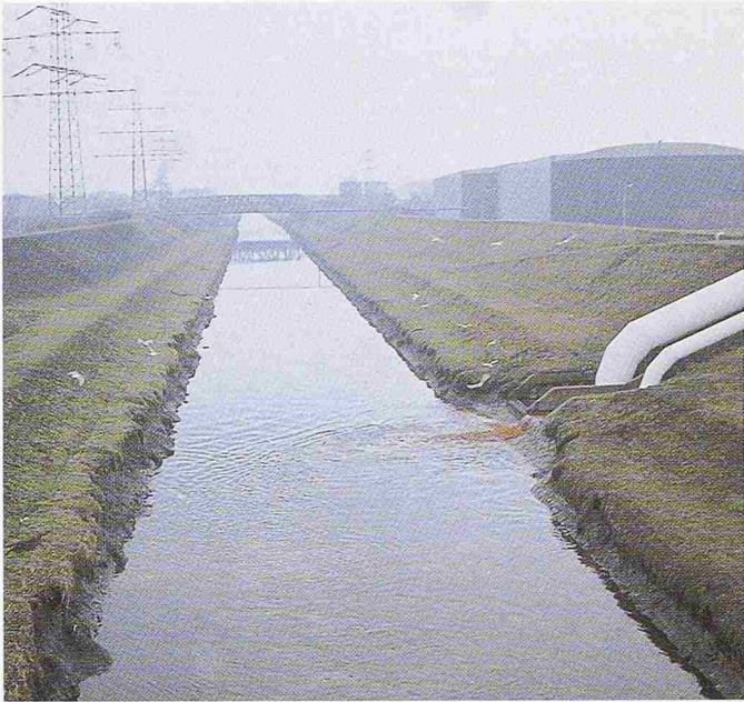
Abwassereinlauf in die Emscher, die im Rahmen der IBA Emscher Park ökologisch umgestaltet werden soll (Foto: IBA Emscher Park)
