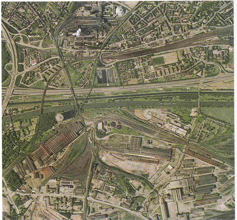
Die Industrielandschaft der Emscher-Region heute: Emscher, Rhein-Herne-Kanal, Bahnlinien und Autobahn A 42 bilden in Ost-West-Richtung ein dichtes Bandinfrastruktur-Bündel, das Industrie- und Siedlungsbereiche und Freiflächen einschliesst (Luftbild des Kommunalverbandes Ruhrgebiet)
