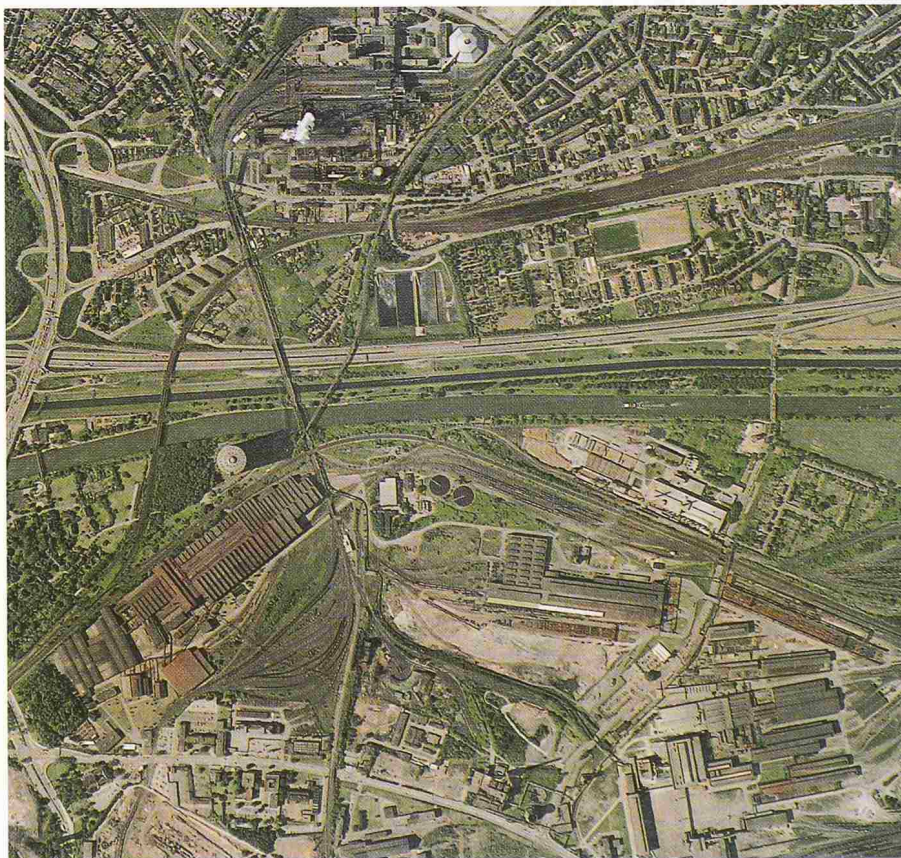
Die Industrielandschaft der Emscher-Region heute: Emscher, Rhein-Herne-Kanal, Bahnlinien und Autobahn A 42 bilden in Ost-West-Richtung ein dichtes Bandinfrastruktur-Bündel, das Industrie- und Siedlungsbereiche und Freiflächen einschliesst (Luftbild des Kommunalverbandes Ruhrgebiet)
