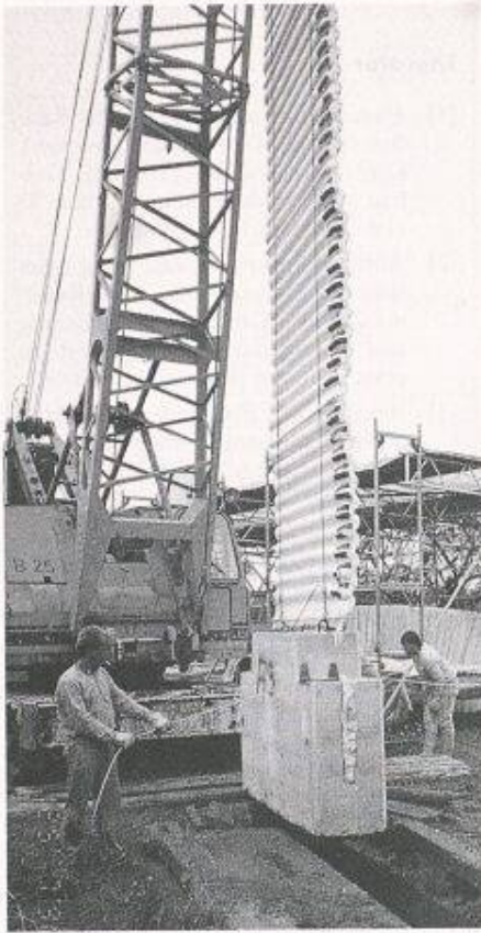
Bild 4. Mit einem Betonfertigteile beschwertes Gasmattelement vor dem Einbau in eine suspensionsgefüllte Schlitzwand
