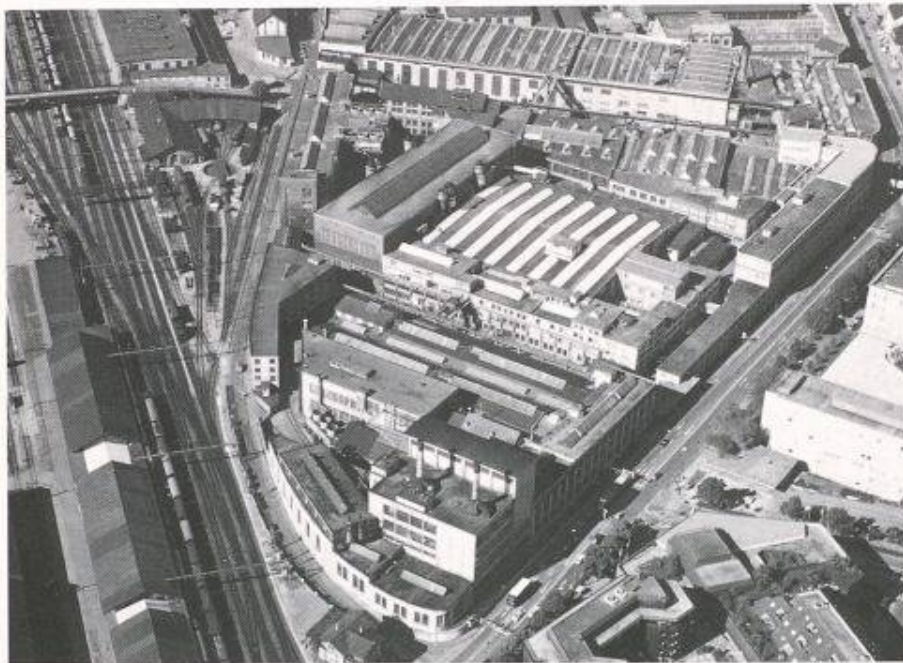
Sulzer-Areal in Winterthur. Das für die Projektierung vorgesehene Areal wird rechts durch die Zürcherstrasse, links durch die Tössfeldstrasse begrenzt. Es reicht bis zum oberen Bildrand
