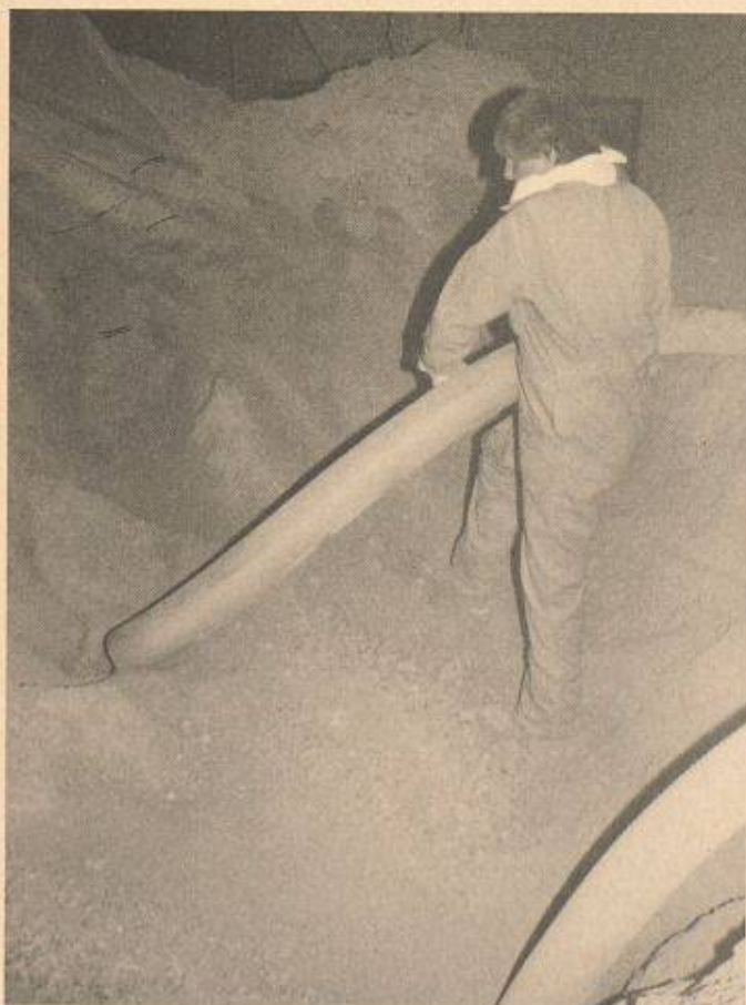
Das Leersaugen von Zementsilos verlangt höchste Leistungen von Personal und Maschinen
