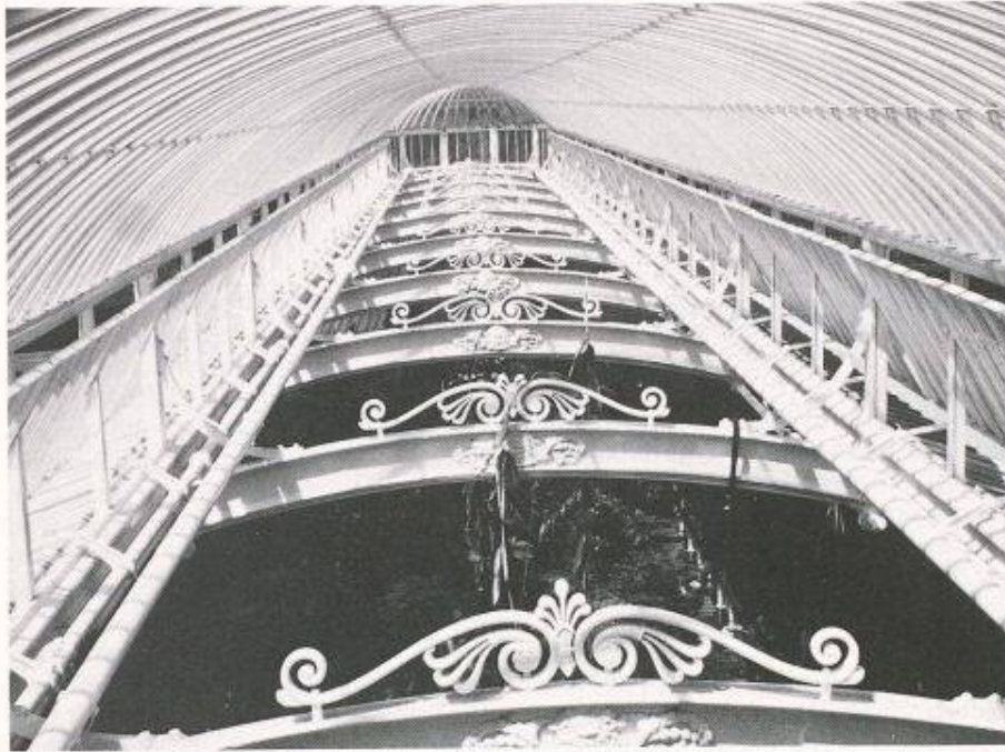
Palmenhaus Kew Gardens, London 1844 bis 1848. Detail des Firstoberlichtes mit eingebauter Entlüftungsmechanik. Die Verantwortung gegenüber dem Bauwerk äussert sich durch die verschwenderische Anordnung von Verzierungsteilen aus Stahlguss.
