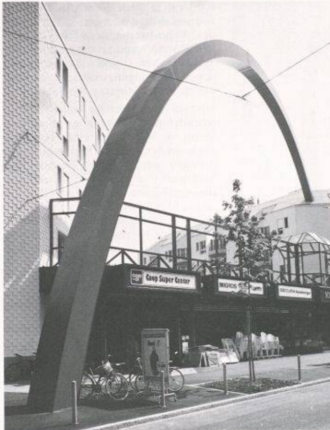
Stahlbogen von Heinz Niederer, Eisenplastiker, Zürich, Solida-Park, Zürich-Altstetten. Ausführung und Montage: Geilinger AG, Winterthur. Mit einer Spannweite von 43 m erhebt sich der elegante Stahlbogen von 22 t Gewicht 21 m über den Betrachter, ihn gleichsam zum Sprung über den Platz hinweg verleitend. Foto: Hauser, Andelfingen.
