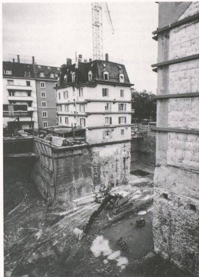
Bild 6. Bereich PAX-Gebäude: Jettinggeräte mit ihren Versorgungsleitungen im Einsatz
