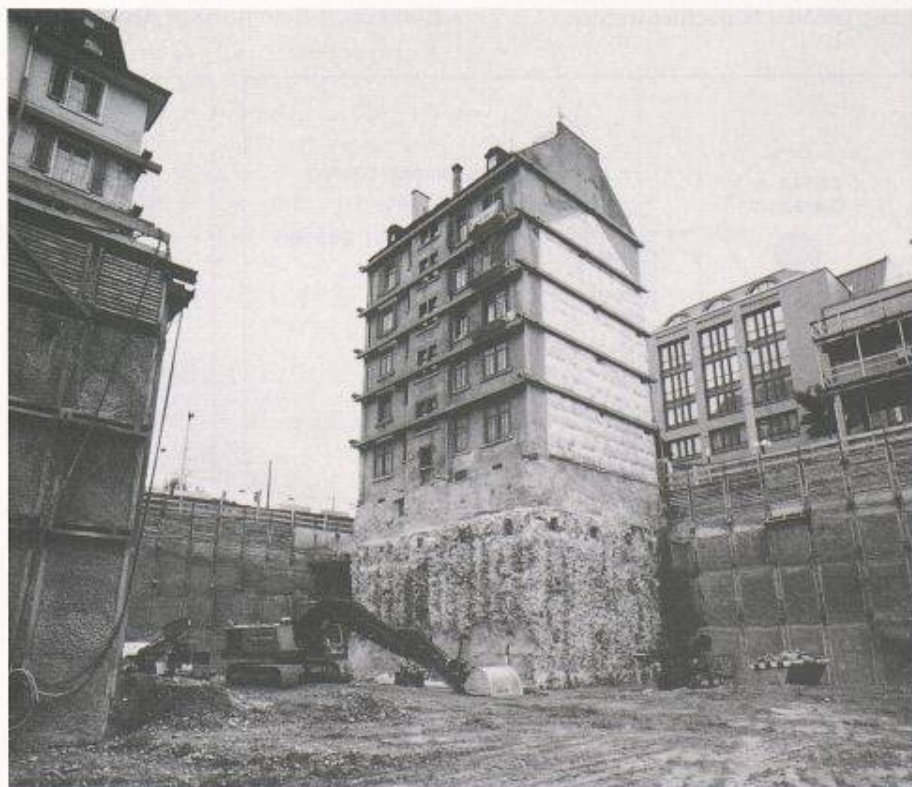
Bild 1. Fassadensicherung/Soilcreteunterfangung Badenerstr. 4, Endaushubphase
