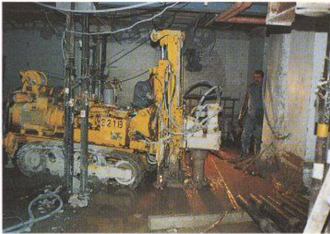
Bild 4. Herstellen der Kleinbohrpfähle im 1. Untergeschoss (lichte Arbeitshöhe: 2,5 m). Diese Kleinbohrpfähle tragen im Bauzustand die neue Bodenplatte des 1. Untergeschosses (= Decke der Passage Bahnhofstrasse)
