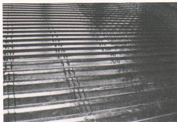
Bild 2. Trapezbleche und Verbundschrauben von oben gesehen
