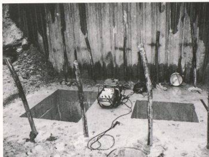
Bild 8. Köcherfundament mit Litzenankern
