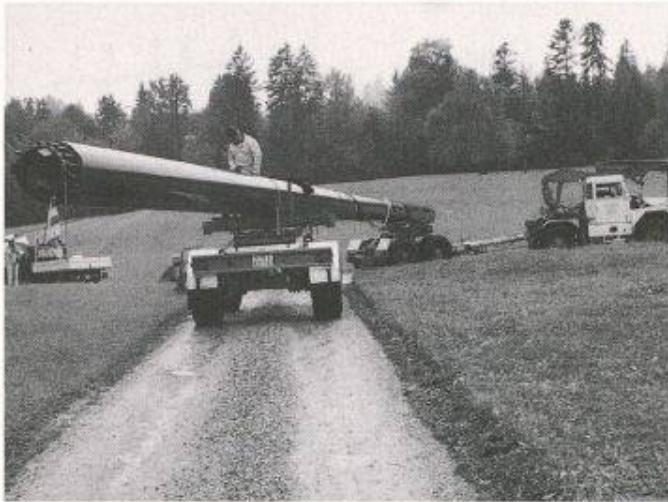
Bild 4. Transport der Mastteile
