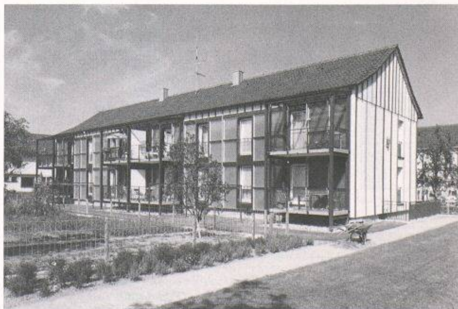
Bild 5. Mehrfamilienhaus Sonnenäckerweg, Freiburg (BRD) mit 120 m 2 passiver TI-Fassade (Foto: Fraunhofer Institut für Solare Energiesysteme, Freiburg (BRD))
