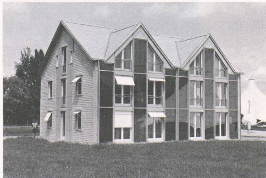
Bild 3. Null-Energie-Haus an der Heureka. Die in der Fassade integrierten Kollektoren sind mit 10 cm dicker Transparenter Isolation abgedeckt
