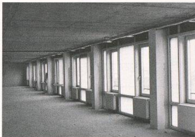
Bild 6. Transparente Isolation zur Tageslichtnutzung im Technologiepark Düsseldorf
