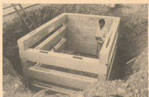
Pflanzgrube, erstellt aus Arconda-Norm-Pflanzgruben-Elementen
