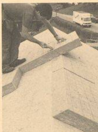
Bild 1. Verlegung Sarnaroc Nova, Bearbeitung am First
