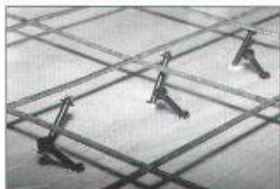
SFS-Verbund-Elemente verbessern das Tragverhalten
