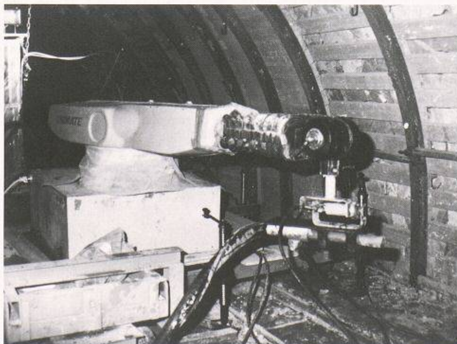
Roboter auf dem Spritzbetonversuchsstand der RUB (Bild: dpa)
