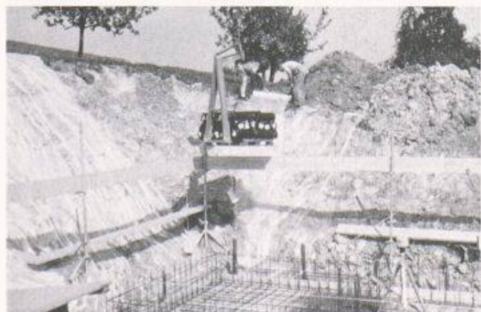
Eine der typischen PE-Anwendungen im Baubereich: Polyethylenfolien schützen Baugruben vor witterungsbedingtem Erdrutschen
