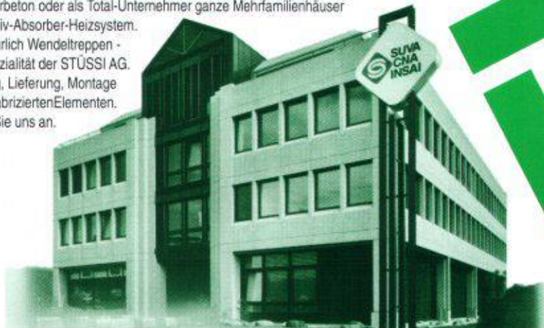
Geschäftshaus Adlikerkreuz, Regensdorf. Rötlich eingefärbte, sandgestrahlte Sandwich-Fassaden.
