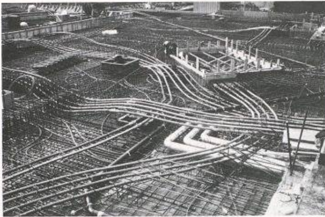
Bild 4. Vorgespannte Abfangdecke
