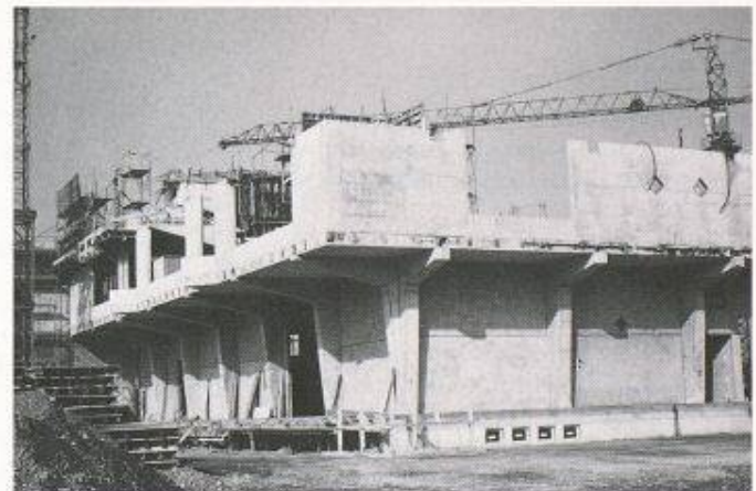
Bild 14. Vorgespannte Winkelstützen zur Unterstützung der Auskragung
