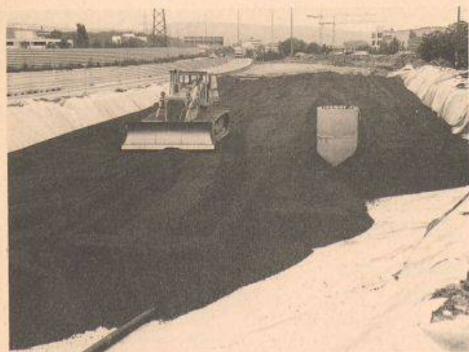
Leca-Blähton im Brüttseller Kreuz: Der setzungsempfindliche Baugrund unter der neuen Fahrbahn wird gegen bedeutend leichteres, aber dennoch mechanisch festes Leca von Hunziker Baustoffe ausgetauscht
