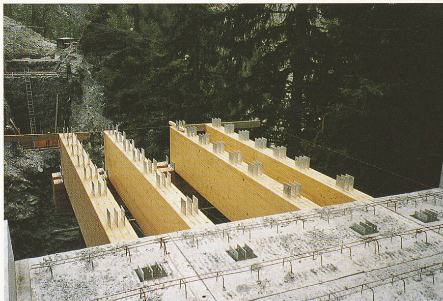
Erste Längsträger mit Schubdübeln sind montiert, die vorderste, 8 cm starke, als Schalung für die Fahrbahn dienende Betonplatte ist versetzt. Zu erkennen sind die Aussparungen für die Dübel
